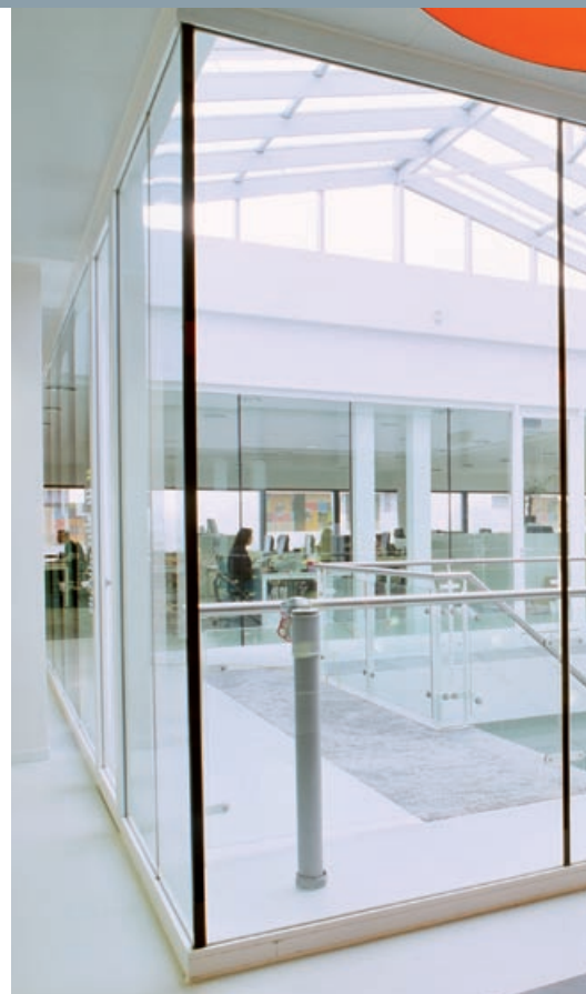
SGG SWISSFLAM STRUCTURE ha sido ensayado también como solución para esquinas.
